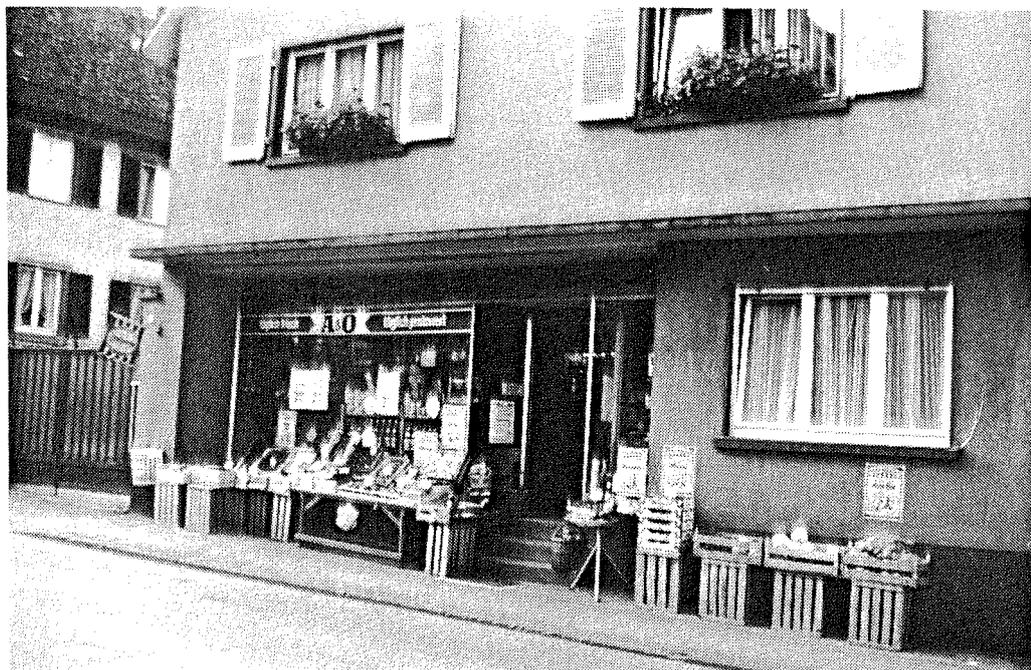
Abb. 28 : Ladengeschäfte in der Hauptstraße. Beide Geschäfte weisen zu großflächige, breit gelagerte Schaufenster auf. Der Zusammenhang mit den Obergeschossen geht so verloren, verstärkt noch durch eine waagerechte Betonplatte als Schutzdach. Schmalere Schaufensterflächen mit Zwischenstützen oder -mauern und unterteilten Vordächern wären eine bessere Lösung.
